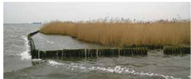
Hetzelfde eiland met een gesloten palenrij, februari 2016 (met doorgang voor zwemmende jongs van vogels en vis)
