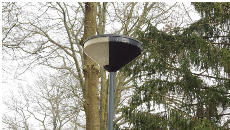
Figuur 3.13 Voorbeeld van een aangepast armatuur: afgeschermd naar boven en naar achteren (bron: Erik Korsten, Zoogdiervereniging).
