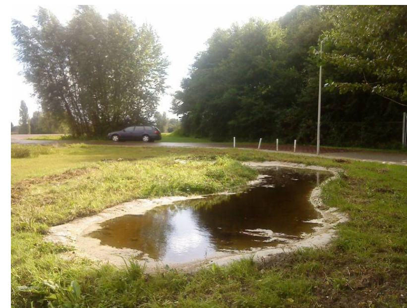
Figuur 16: Poel aangelegd op aangrenzend perceel. De poel heeft een betonnen vloer, met daarover zand. Deze is eenvoudig periodiek te schonen, waarmee de poel duurzaam te gebruiken is voor de rugstreeppad. Let ook op de ondiepe oeverzone (bron: Gerard Smit).
