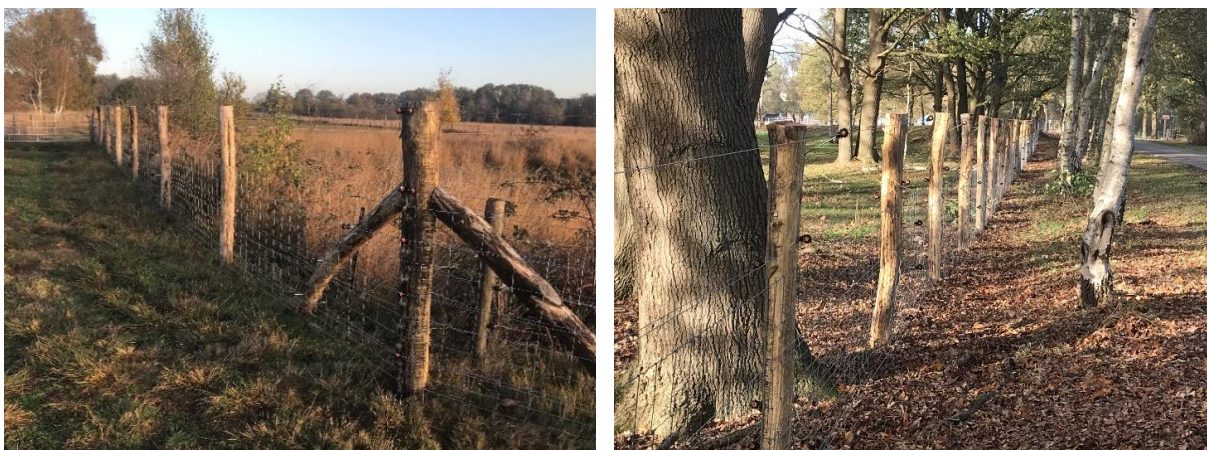
Figuur 8. Aanpassing raster Het Wierdense Veld, verhoging raster en stroomdraden aan buitenzijde.
