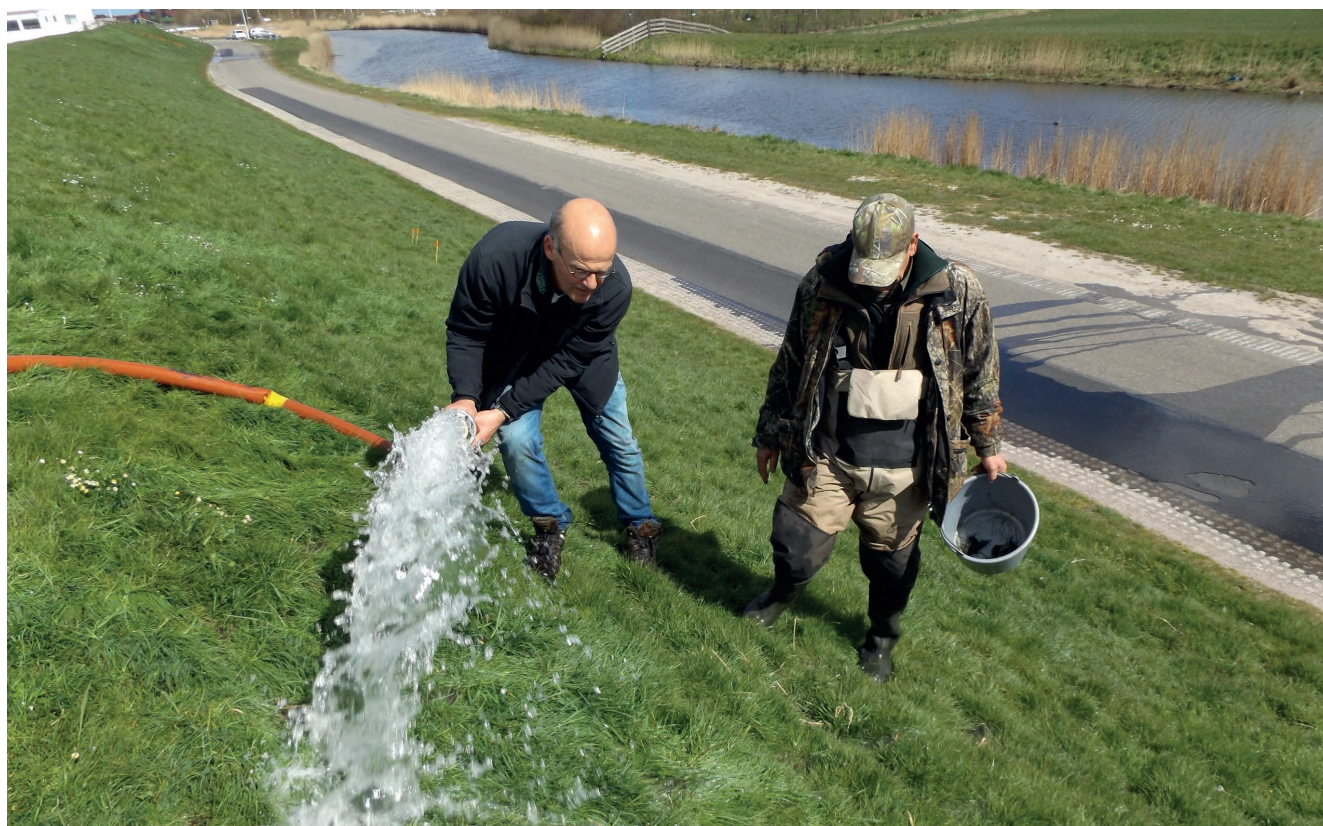
De waterkering wordt tegen Veldmuis beschermd met water
