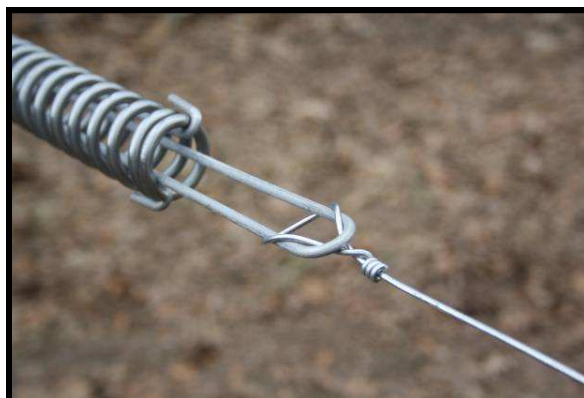
Figuur 4: detail van de draadverbinding.
