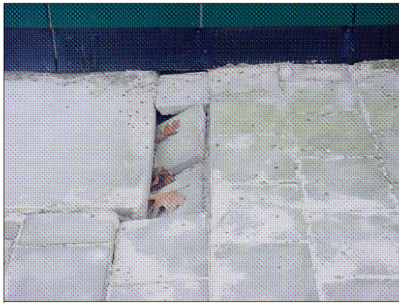
Figuur 3.3: Verzakking als gevolg van graafactiviteiten van konijnen (bron: Faunabeheereenheid Noord-Brabant, 2007)
