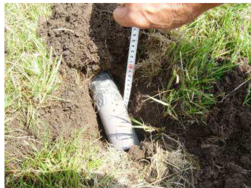
Foto 15. Plaatsing koker in rit.
