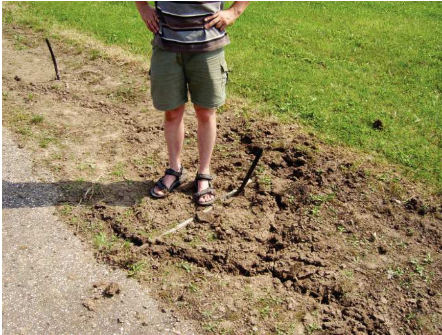
Foto 20. Zichtbare schade aan rit rondom toepasser (30-07-2008).
