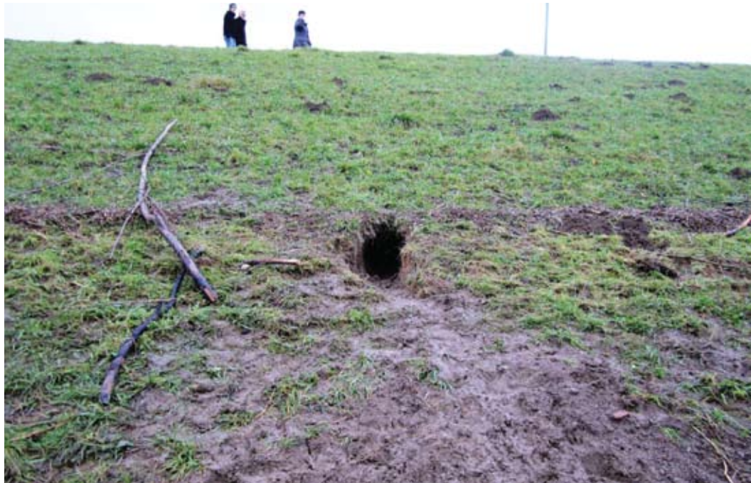
Beverhol in bandijk bij Gendt na hoogwater medio januari 2011.
