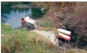
Hoofdstuk 3, pagina 44: Drainagebuizen door beverdam.
