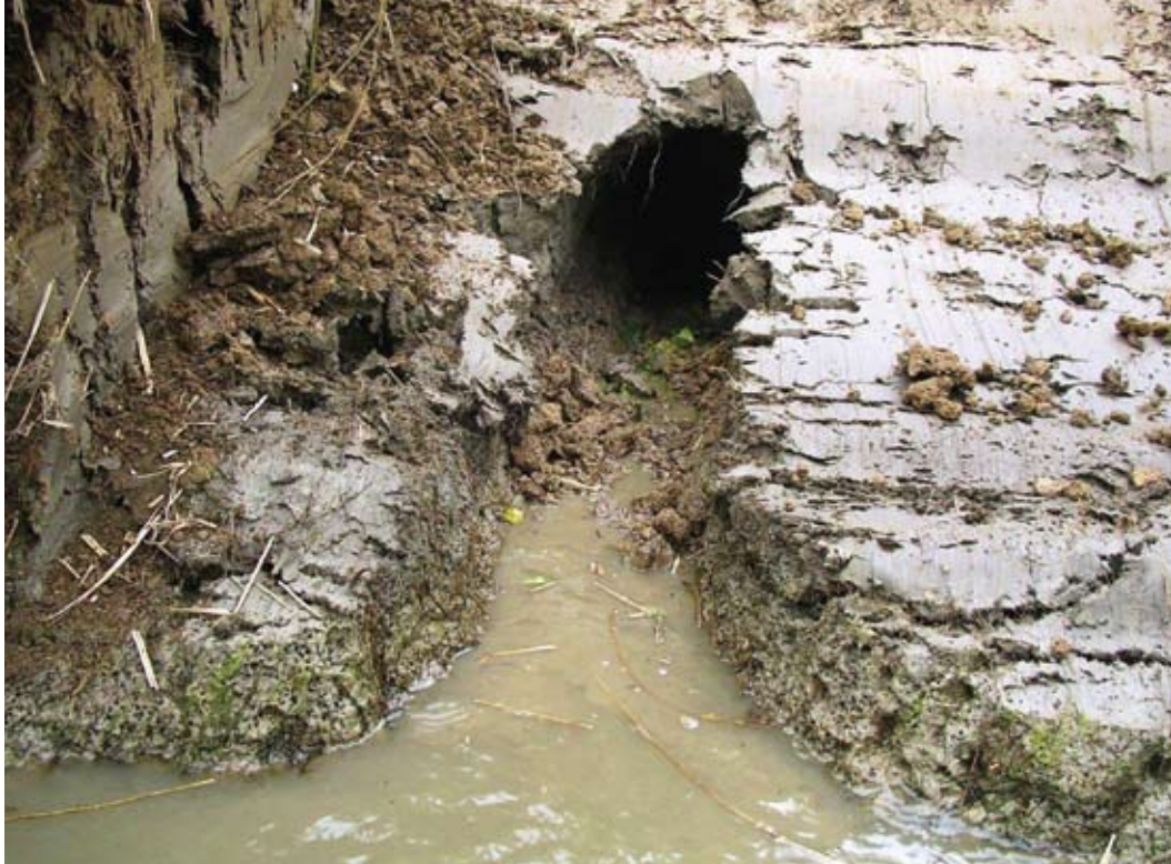
Uitgegraven beverhol in het bermtalud van de Ooijse Bandijk na graverij door bevers in 2004 (Foto muskusrattenbestrijding Gelderse Waterschappen).
