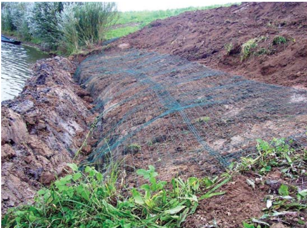
Het aanbrengen van gaas in het talud van de Ooijse Bandijk na graverij door bevers in 2004 (Foto muskusrattenbestrijding Gelderse Waterschappen).
