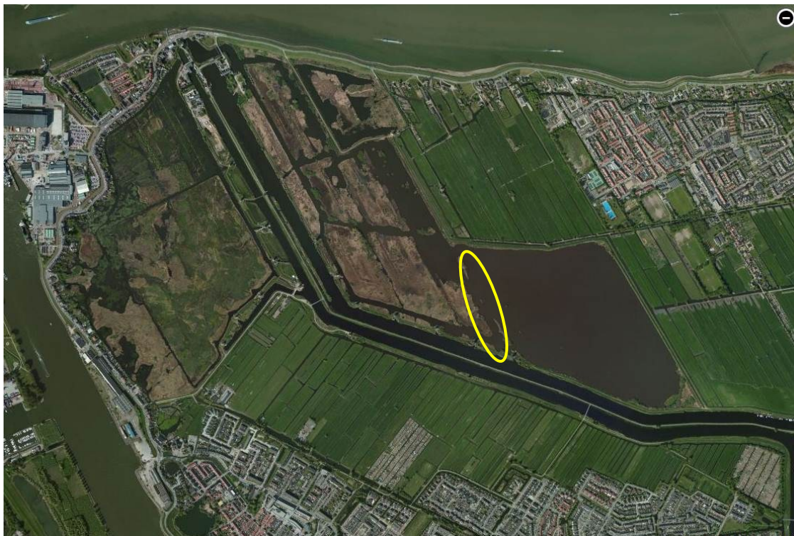
Figuur.5.1 Luwtestructuur in de Hoge van de Overwaard om de golfoploop richting de rietgorzen te dempen.
