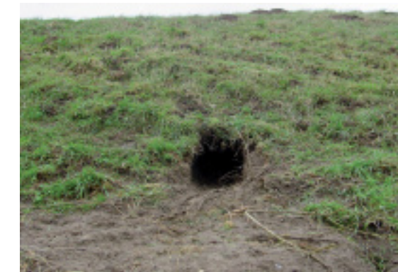
Ingang van beverhol halverwege een dijklichaam, gegraven tijdens hoogwater. Foto Waterschap Rivierenland
